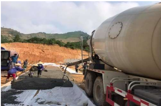
Bê tông Geopolymer thi công đường giao thông nông thôn
