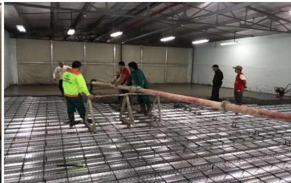
Bê tông Geopolymer thi công trại chăn nuôi gia cầm
